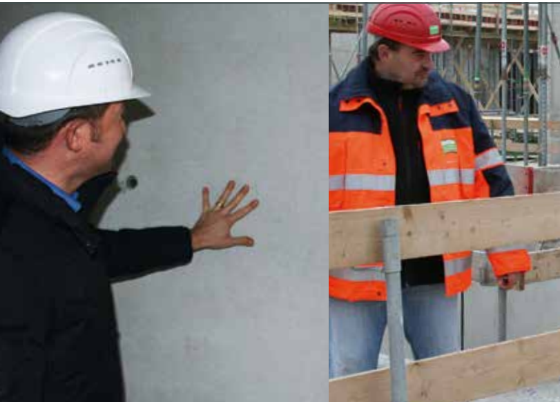
Polier M. Wenzel (r.) und Michael Hörmann bei der Baubegehung und Begutachtung des Sichtbeton.
