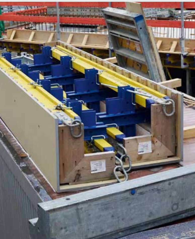
Vorbereitete Schalelemente mit melaminfilm-beschichteten Schlaungsplatten der Westag & Getalit AG.
