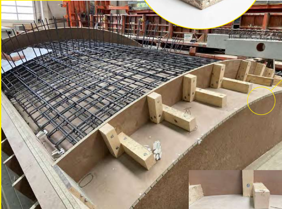
Gebogenes Wandelement mit rückwärtigem Einschnitt der WSP Super 400 bis zur Deckschicht
