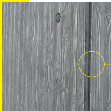
Hochwasserschutz Eisfeld, Thüringen
