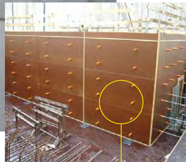
Vorstellungsschalung mit großen Konen
