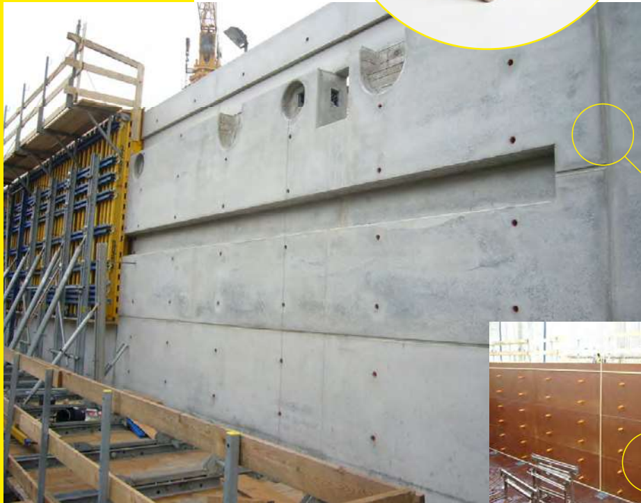
Kletterschalung City-Tunnel, Leipzig
