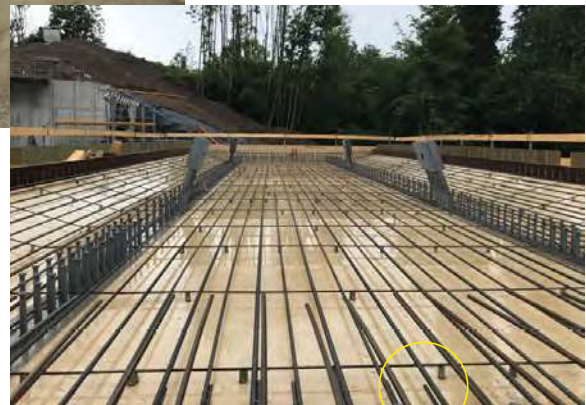
Überbauschalung Brücke, Wangen
