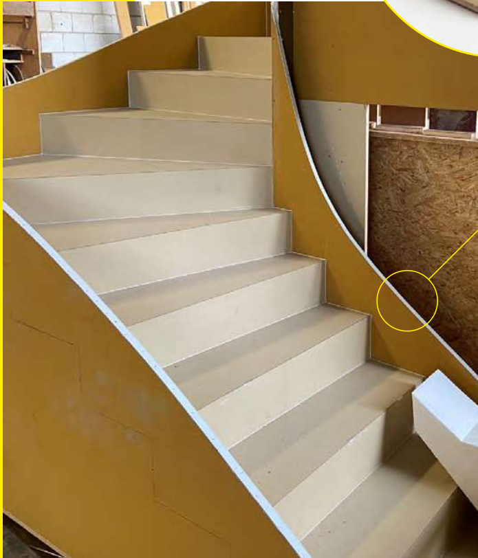
Treppenschalung, Stufen Magnoplan MF, Seitenschalung Bonaboard 260
